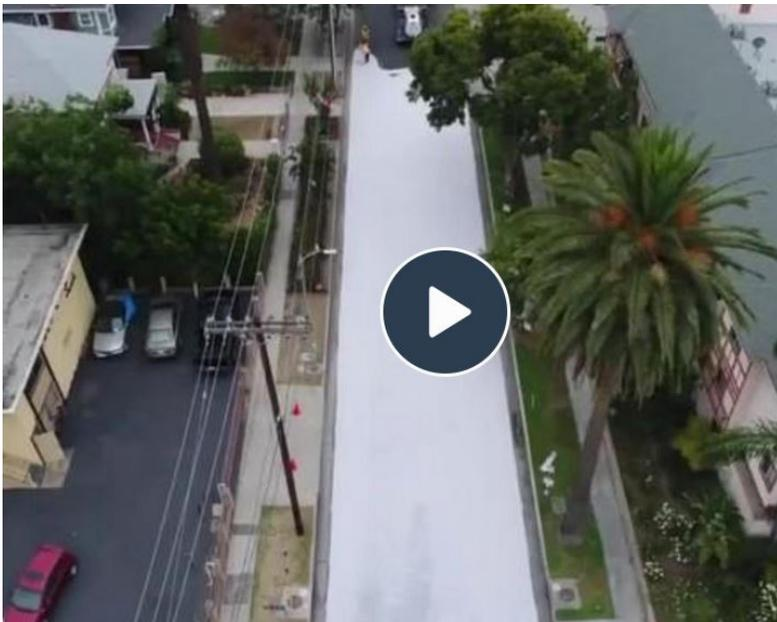
Los Angeles (CA, USA) streicht bereits seit 2018 einige seiner Straßen weiß. Grund dafür ist der Klimawandel. Denn die spezielle grauweiße Beschichtung namens „CoolSeal“ hilft die Sonnenstrahlen vom Asphalt zu reflektieren, sodass weniger Wärme absorbiert wird. Angaben des zuständigen städtischen
