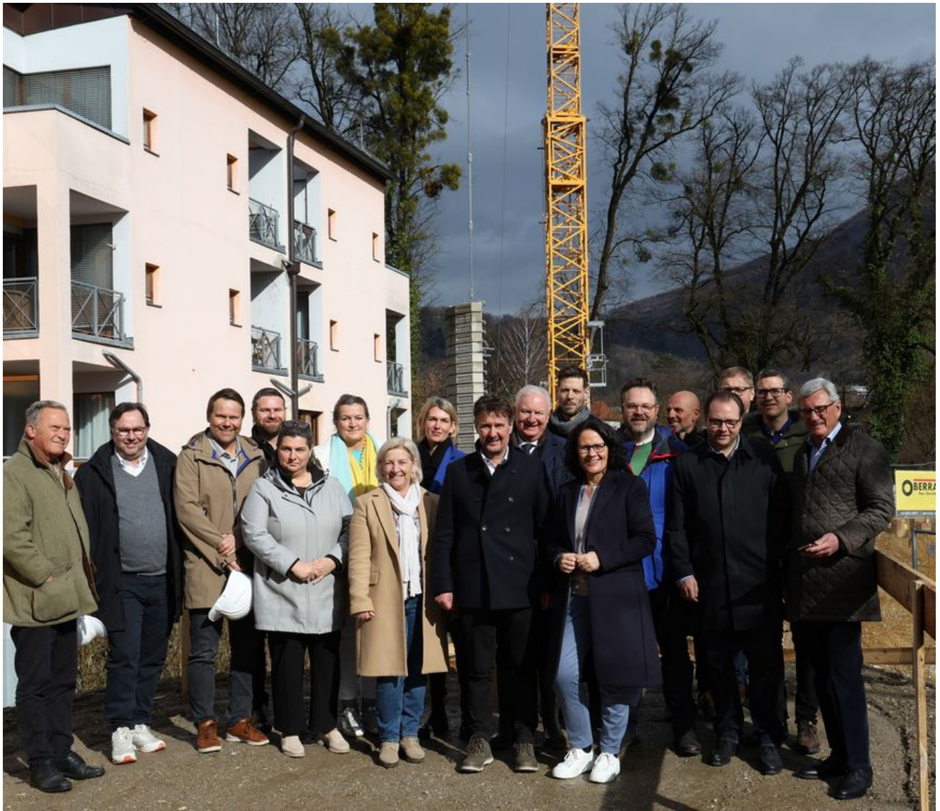
Zahlreiche Gäste bei der Baustelleneröffnung - darunter ÖJAB-Geschäftsführerin Monika Schüssler, Sozial-Stadträtin Andrea Brandner, Wohnbau-Landesrat Martin Zauner, Gesundheits-Landesrätin Daniela Gutschi und Salzburgs Bürgermeister Harald Preuner.
